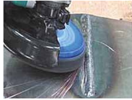
Usinage des cordons de soudure
