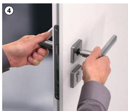
4 Assembler les poignées et serrer la vis pointeau
