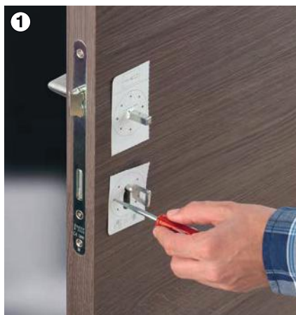
1 Positionner le gabarit à l'aide de la clé, et marquer les emplacements des trous de guidage sur le panneau de porte.
