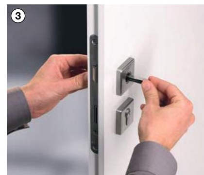
3 Placer le carré profilé à lamelle
