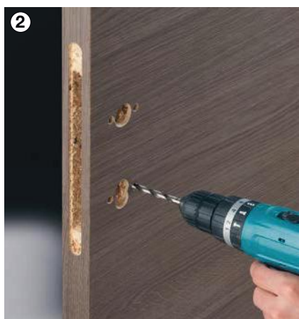
2 Percer les trous de guidage pour les piliers (pour cette étape, retirer la serrure).
