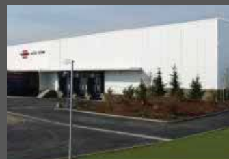
Lectra Technik Ges.m.b.H. 🇦🇹 Taufkirchen Autriche / Oostenrijk
